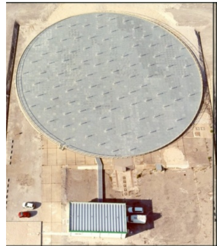
Fig. 1.2 – Récepteurs du radar GRAVES, composé d’un grand réseau d’antennes. [B]
