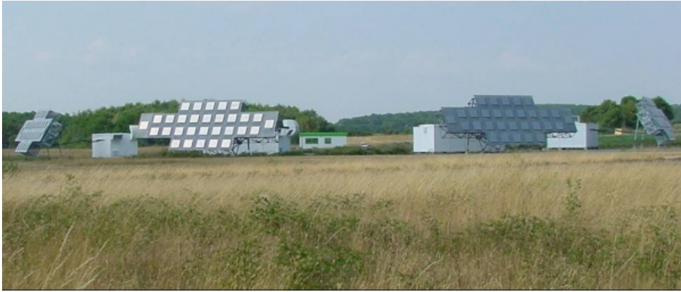
Fig. 1.1 – Emetteurs du radar GRAVES, situé entre Dijon et Vesoul. [B]
