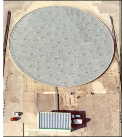
Fig. 1.2 – Récepteurs du radar GRAVES, composé d'un grand réseau d'antennes de réception. [B]
