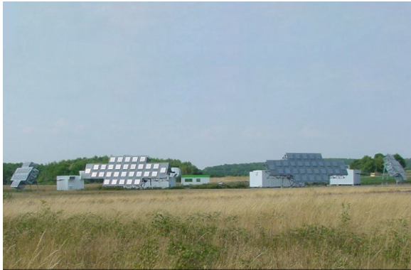
Figure 1 – Émetteurs du radar GRAVES, situé entre Dijon et Vesoul. Fréquence d'émission à 143.05MHz.
